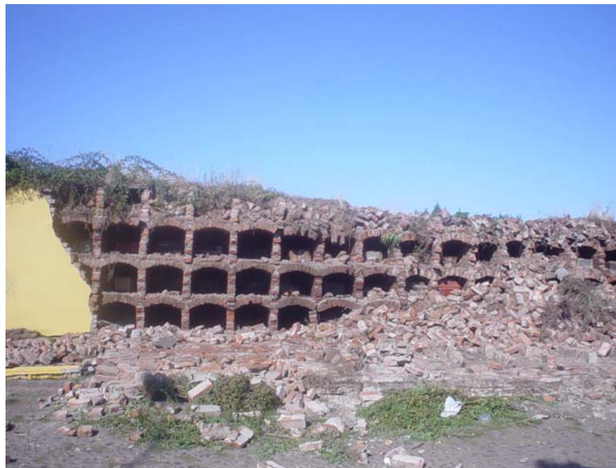
VISTA EXTERIOR POR CALLE BRICEÑO
