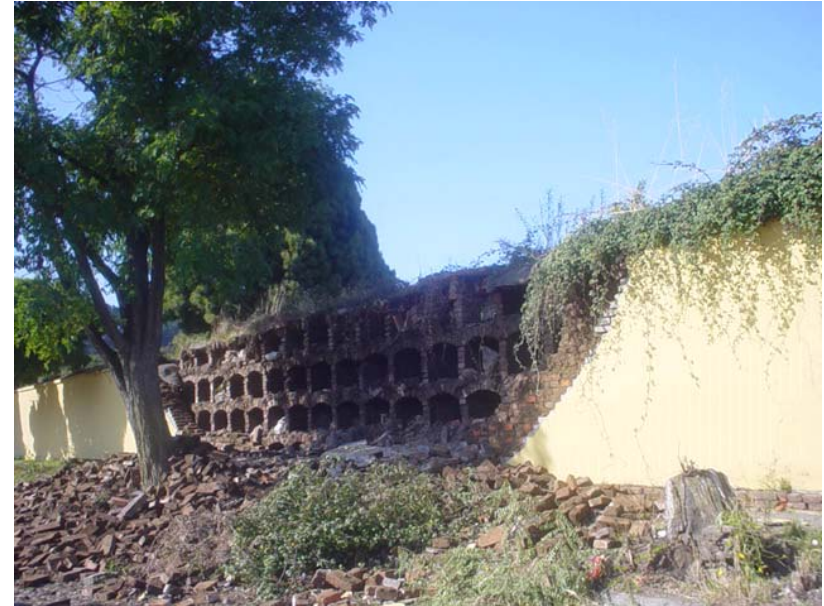
VISTA EXTERIOR POR CALLE BRICEÑO
