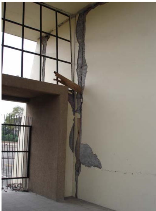
DETALLE INTERIOR MURO AGRIETADO
