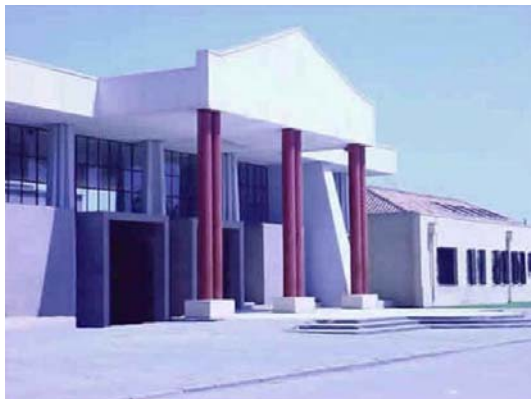
VISTA EXTERIOR DEL EDIFICIO
