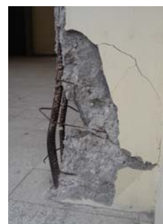
DETALLE INTERIOR MURO AGRIETADO
